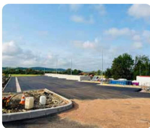
Avancée des travaux de la déchetterie
