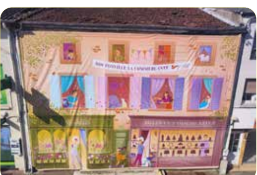
Installation d'une bâche rue de la République
