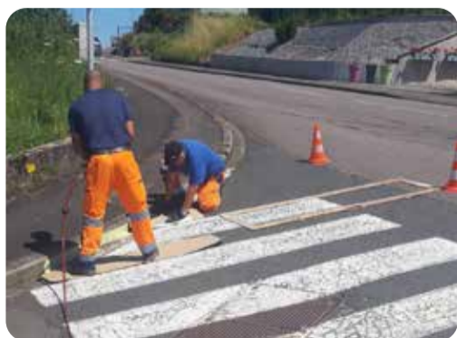
Réfection des peintures routières
