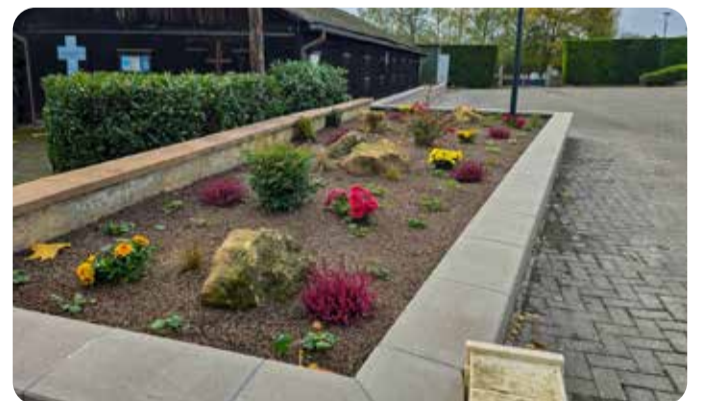
Réfection du massif à l'entrée du parking rue du 27 novembre
