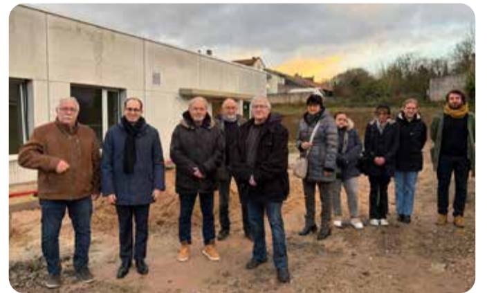
Visite de chantier à l'Îlot Tendresse
