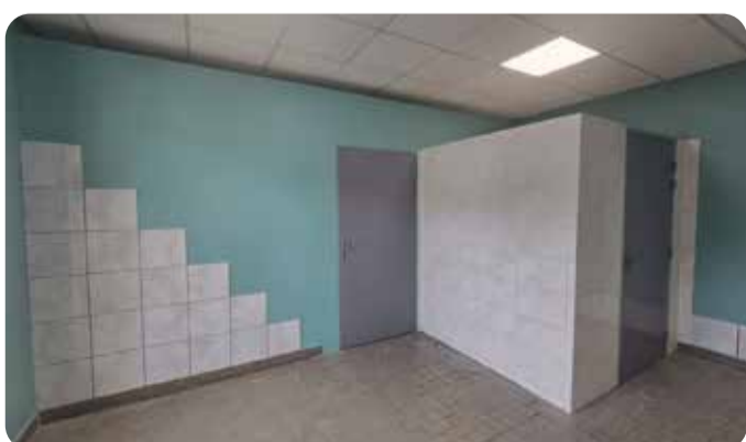
Réfection des toilettes à l'école Pol Grandjean
