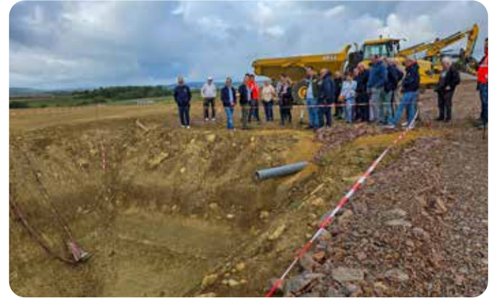
Visite du chantier Ecovégétal
