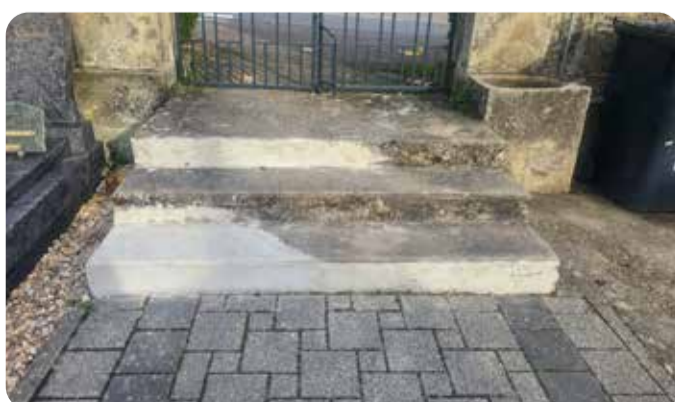
Réparation de marches d'escalier au cimetière
